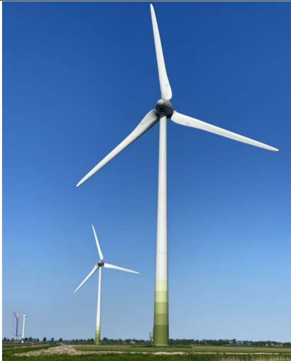
Figuur 4 Groene markeringen op de mast van een windturbine
